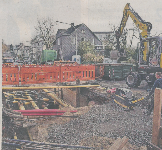
Die Stadtwerke haben damit begonnen, das große Loch an der Lindenallee wieder zu verfüllen.
