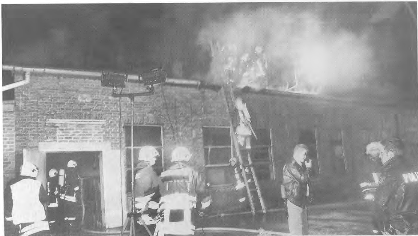
Großeinsatz in der Unterkohlfurth: Dort geriet am Samstagabend der Dachstuhl eines Veredelungsbetriebes in Brand. Dort musste die Feuerwehr viele Glutnester löschen. Der Sachschaden beläuft sich auf 80000 Euro. Foto: Wolfgang Westerholz
