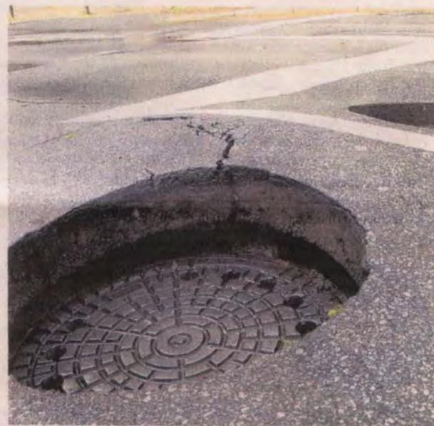
Die Wassermassen aus der Kanalisation hatten sofort den Straßenbelag angehoben – die Schäden sind immens.
