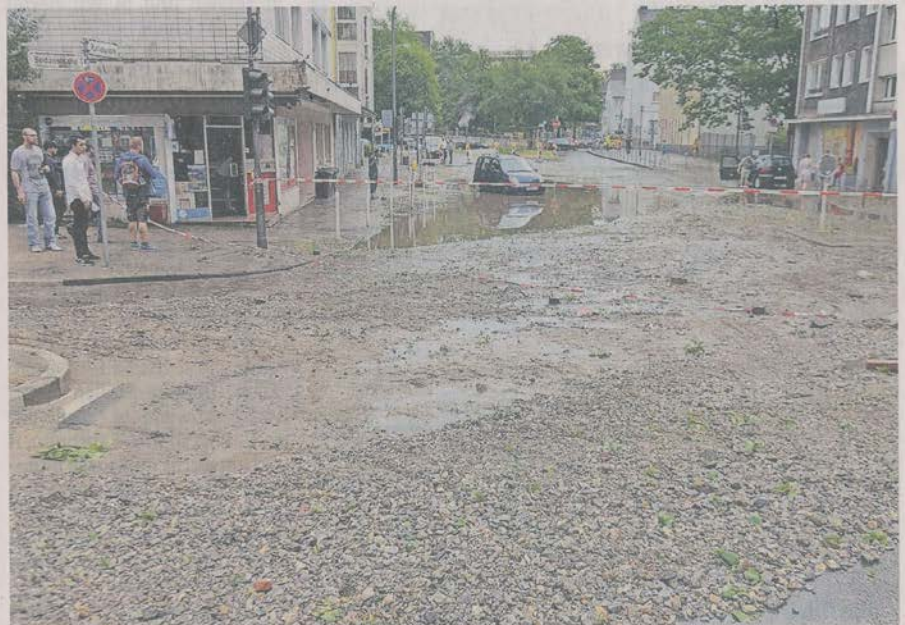
Auf der Bleicherstraße sieht es nach dem Starkregen schlimm aus.
