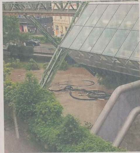
Nicht nur Äste und Müll trieben in der Wupper, sondern auch ein riesiger Schlauch.
