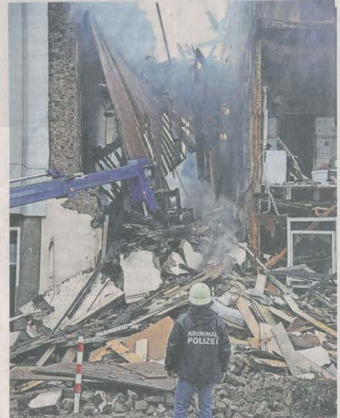
Schließlich wird die Ruine abgerissen.
