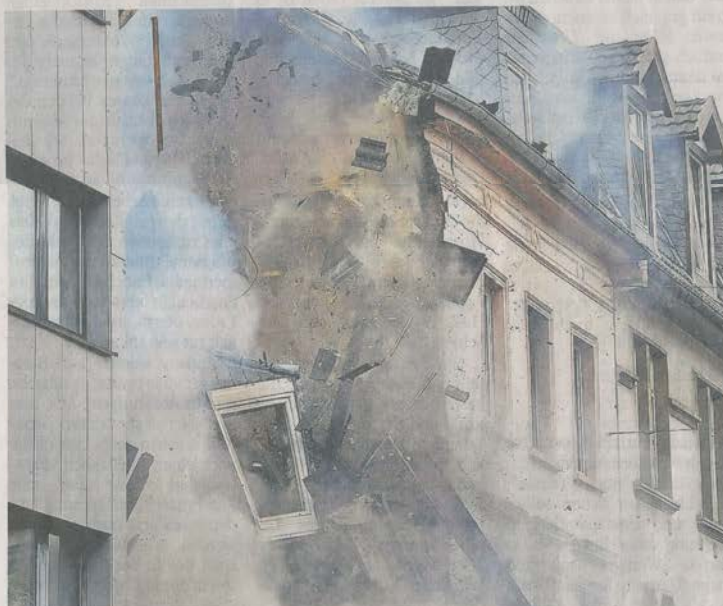
Am Morgen nach der Explosion stürzt dann ein Teil des ausgebrannten Gebäudes komplett ein.
