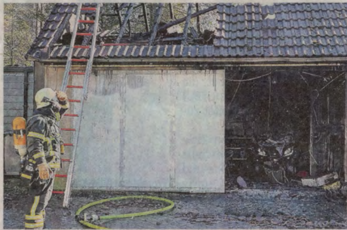
Die Feuerwehr war nach einer Explosion in Hintersudberg im Einsatz. Foto: afi
