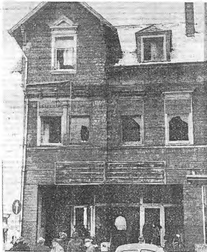
Völlig zerstört. Das Laden-Lokal von „Moden-Krumm“.
