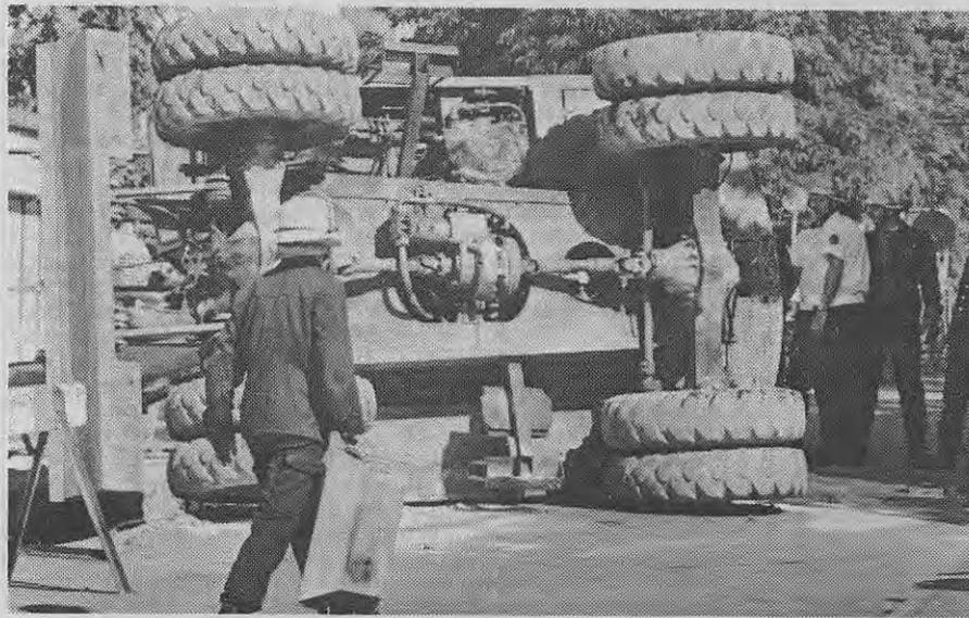
Zu nah an den abschüssigen Grundstücksrand rangierte gestern ein Baggerführer sein 16 Tonnen schweres Gefährt bei Ausschachtungsarbeiten gegenüber dem Gartenhallenbad Cronenberg. Der Bagger fiel um und schob eine Stützmauer auf die Straße „Zum Tal“. Der Fahrer verletzt sich leicht. WZ-Foto: Westerholz
