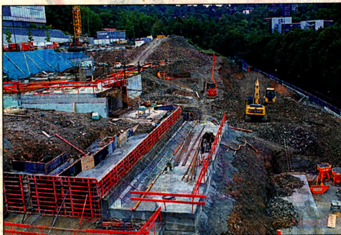
Auf dieser Großbaustelle zwischen Gauß- und Max-Horkheimer-Straße wurde der Blindgänger bei Baggerarbeiten entdeckt.
